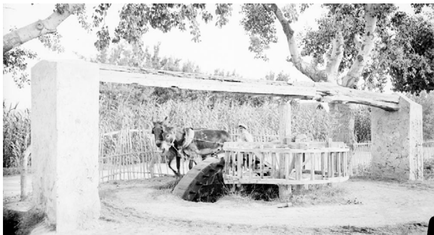
Figura. 4. Cenia y aceña con tracción animal, huerta de Orihuela (1920 – 1936). Otto Wunderlich. Archivo Wunderlich, IPCE, Ministerio de Educación, Cultura y Deporte.
